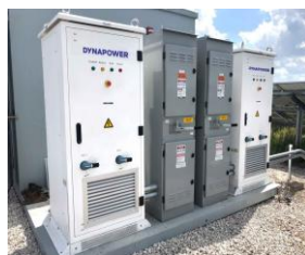
Figuur 23: Voorbeelden van een omvormer van ca 6 MVA. Bron: Dynapower, SMA
