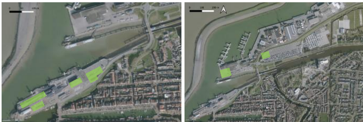
Figuur 3. Luchtfoto haven van Harlingen met ruimtelijke kansen. Bron: Landelijke voorziening beeldmateriaal.
