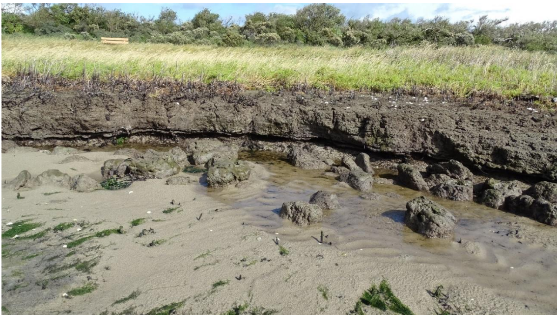
Figuur 2. Steile kwelderrand onder het Oerd, ontstaan door afkalving (foto: augustus 2020).
