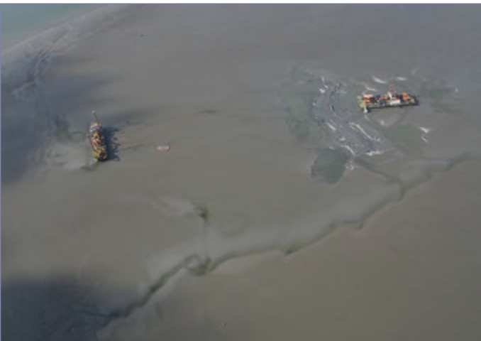
Baggerwerkzaamheden op de Waddenzee. (Foto: H. Venema, PRW)
