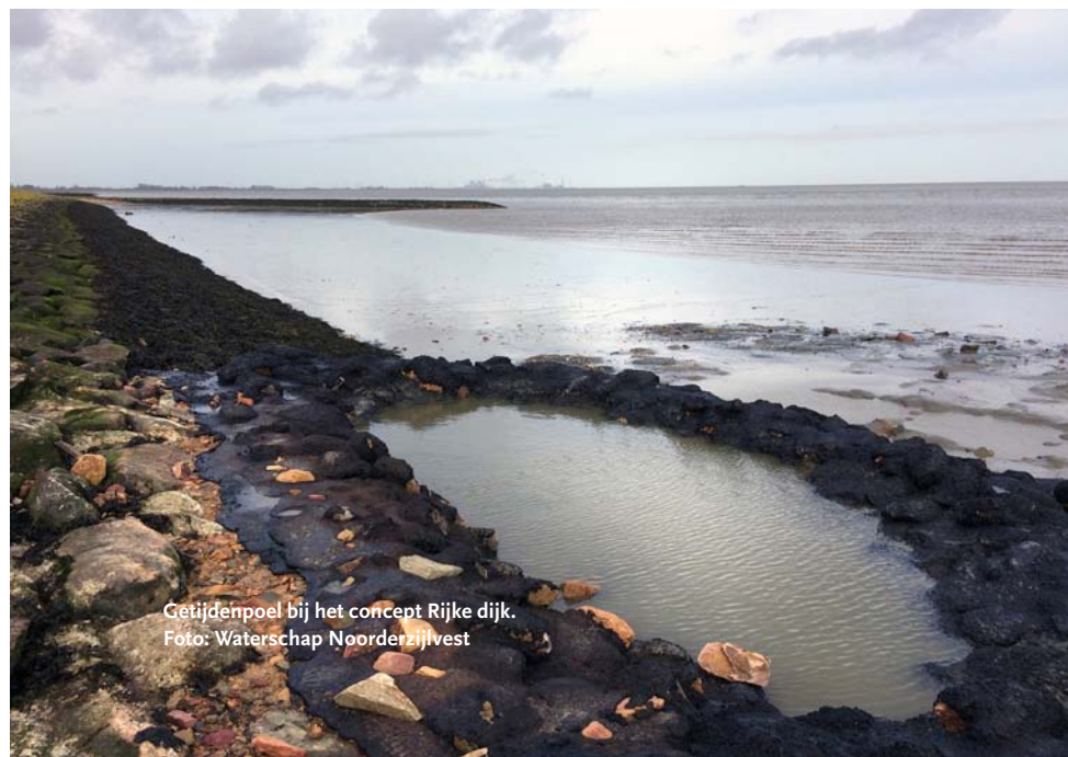
Test van de sterkte van grasbekleding van een dijk door middel van 'Golfplooproef'. Foto: Waterschap Hunze en Aa's
