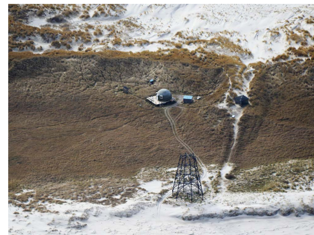
De huidige bebouwing op Rottumeroog
